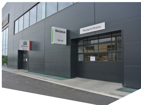
Porte di servizio
